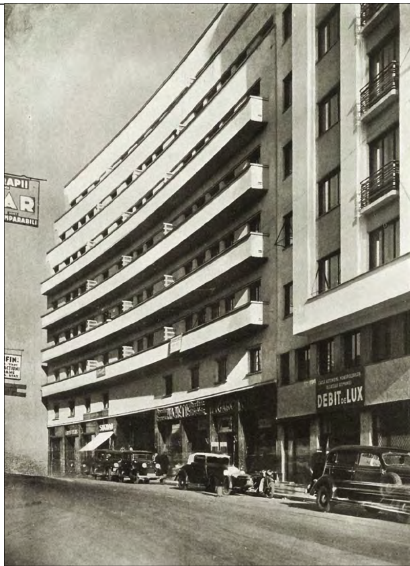
Blocul Societății Generală - lucrări de betonare executate de ing. Luigi Cora
